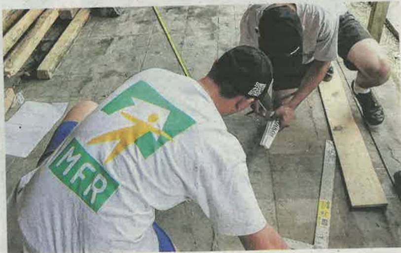
Les élèves ont participé à un chantier de charpente avec les jeunes au Nicaragua. Photo MFR
